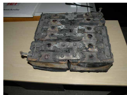
Abbildung 5: Durch Überladung mit Absicht abgebranntes Modul
